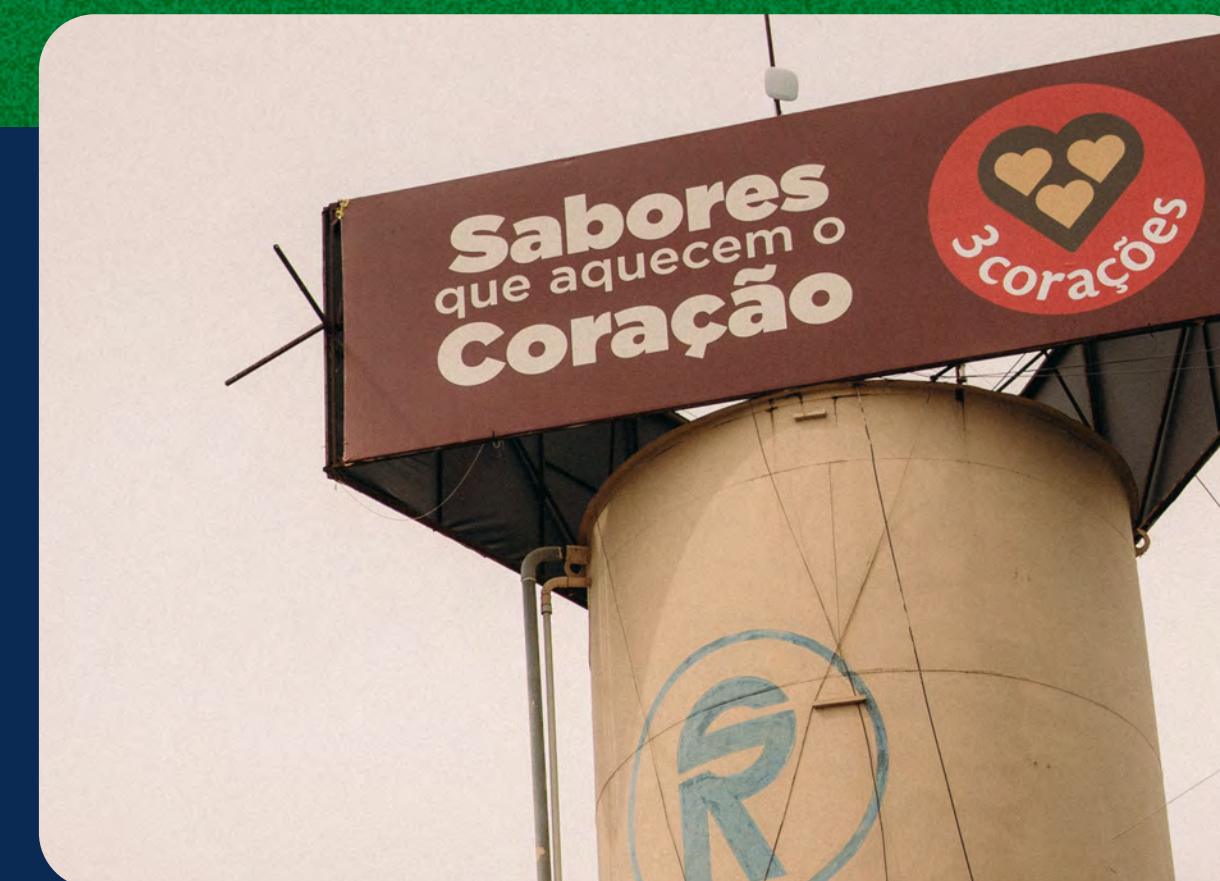
Caixa d'Água Quantidade: 01 Formato: 6 x 2 m
